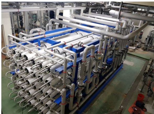
폐수 재이용 RO설비 설치
